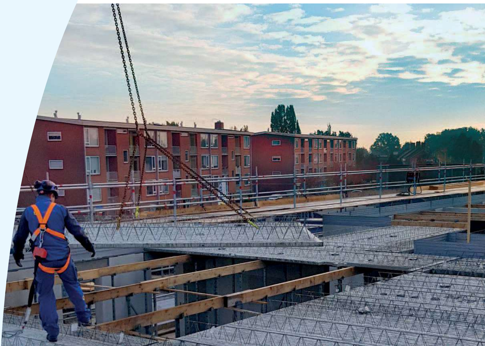
Bouwwerkzaamheden aan de Drostenstraat
